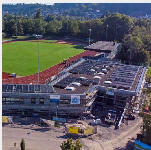
„VfL Center | Gebäude 2“ – Eröffnung im Dezember 2021
