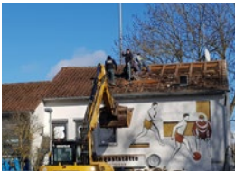
Abriss Stadion Gaststätte
