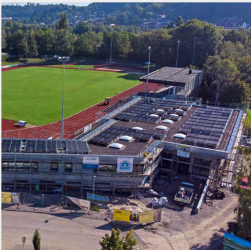
„VfL Center | Gebäude 2“ - Eröffnung im Dezember 2021
